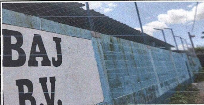
Foto 6: En esta caída de agua pluvial que afecta la pared que esta recién construida, y por no alcanzar los recursos economicos no se protegió en su momento por que se necesita colocar canalex.
